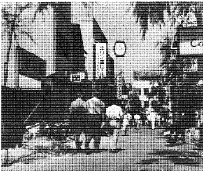
▲道幅を6呎に拡張して工事を急ぐ（昭和31年頃） 右は道路、水道、下水、電気等の諸工事が完了して お祝いの会の記念写真（昭和32年）
