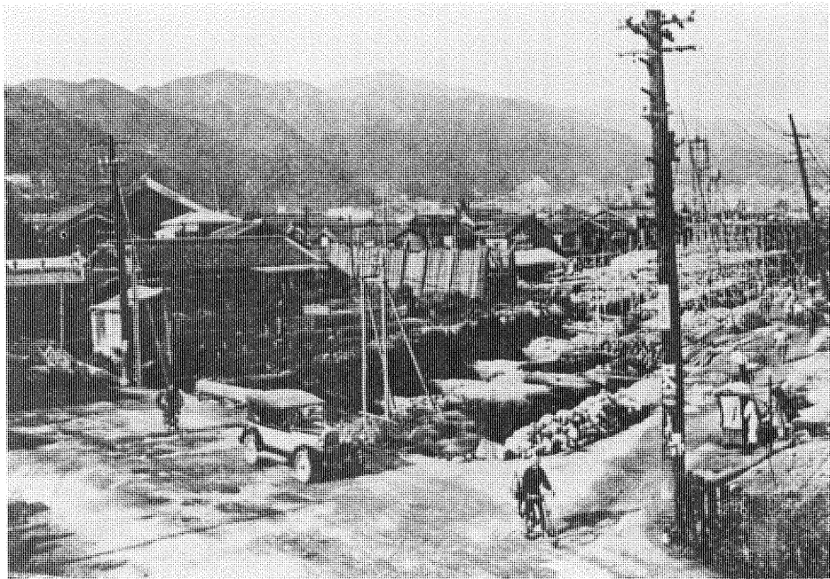
鉄道高架基礎工事中の滝道踏切付近で、二二が現在の三宮駅となった。（昭和四年九月写）
